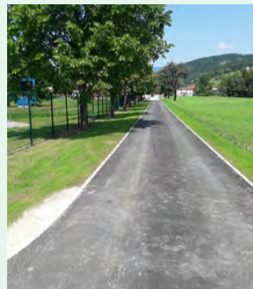
Rekonstrukcija dela Šolske ceste, ki je zdaj v celoti asfaltirana.
